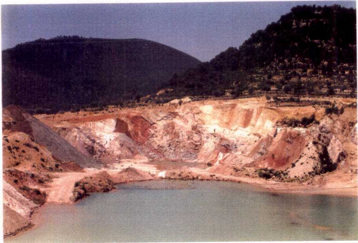
Charca invadiendo las pistas de acceso a la corta.
