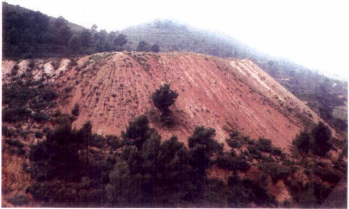
Base del talud ocupando suelo vegetal
