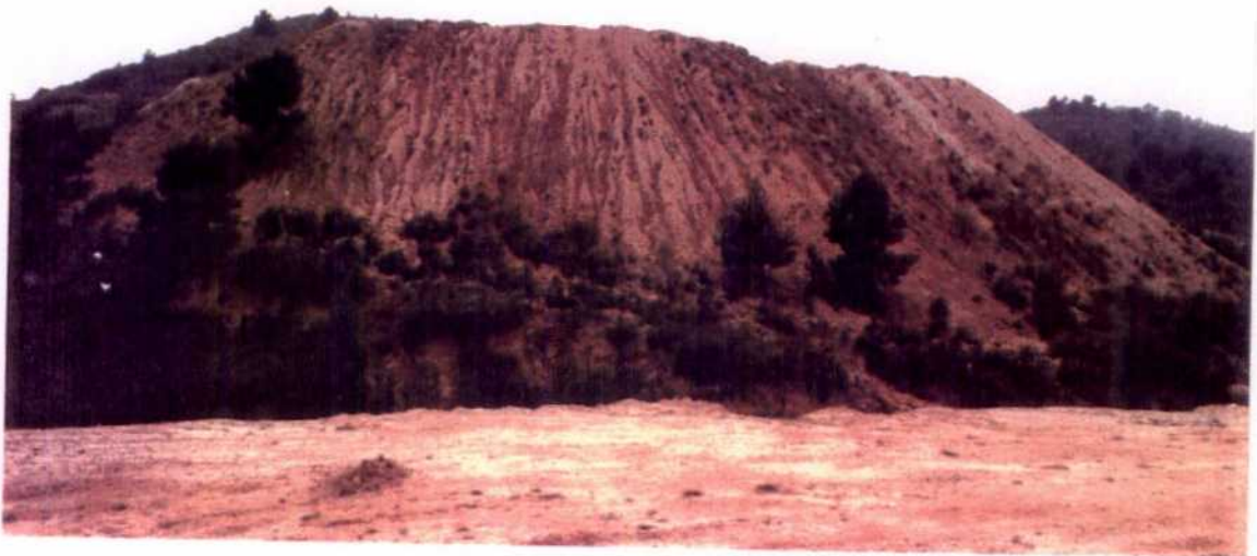
Erosión (cárcavas y canalizaciones) en el talud
