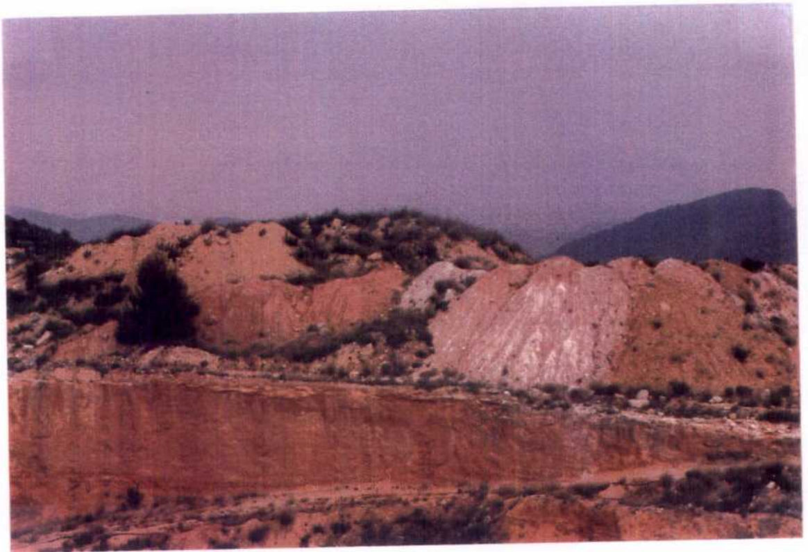
Revegetación y erosión (cárcavas) en los taludes.
