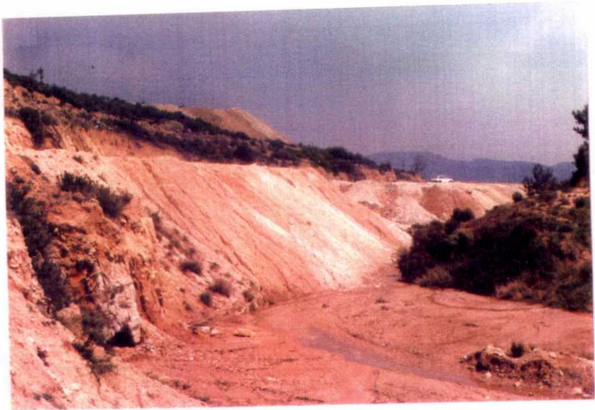
Plataforma y borde del talud.
